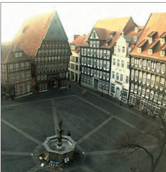
Durch den Wiederaufbau der West- und Nordseite des Platzes, inklusive des ehemaligen Limprichtschen Hauses, erhielt der Hildesheimer Marktplatz wieder seine historische Form. Die offizielle Einweihung war am 22.4.1990. © CL, Stadt Hildesheim, Webcam-Bild vom 20.2.2021
